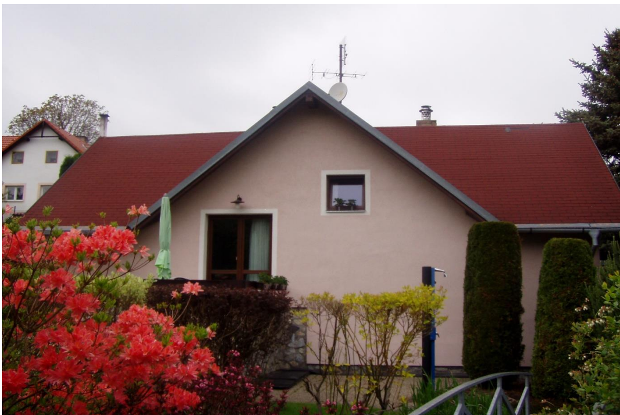
Celkový pohled na střechu
